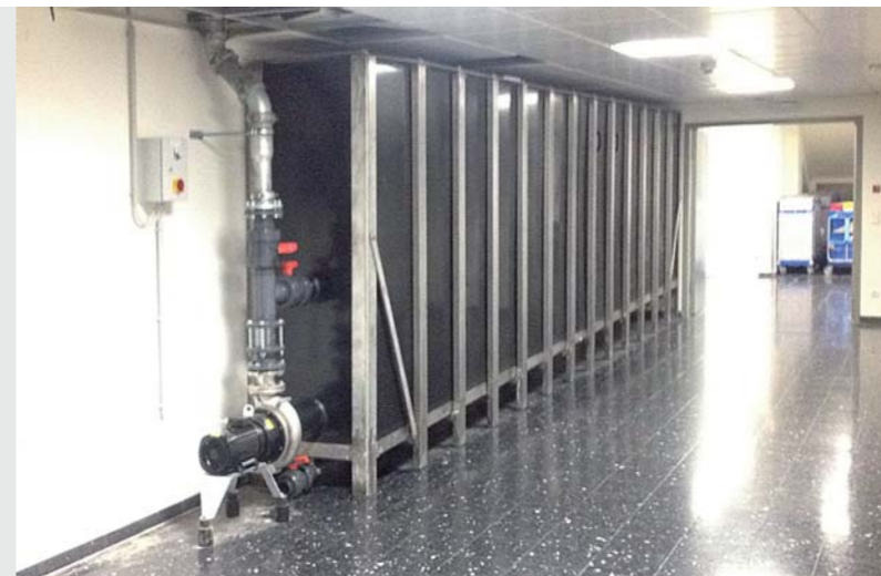
Sonderlösung Tanksystem: Breite nur 70 cm Fassungsvermögen: 14.000 Liter mit Absaug- und Homogenisierungspumpe
