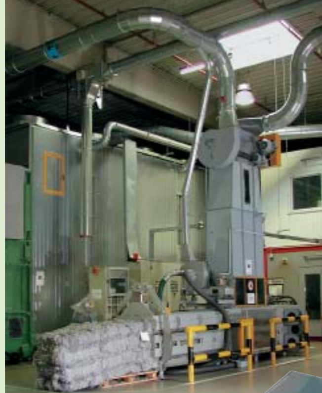
...Verpressen von Dämmmaterial – Zuführung mittels Absaugung
