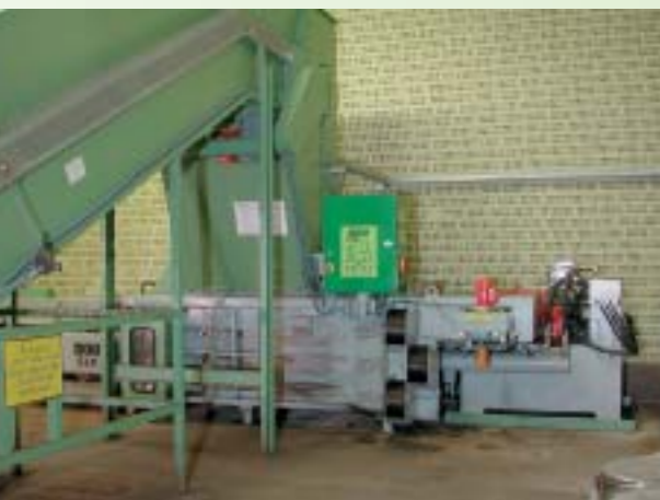
...Befüllung der Presse durch Förderband
